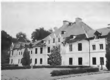
Steinort: Das seit Jahrzehnten verfallende Lehndorffsche Gutshaus.
