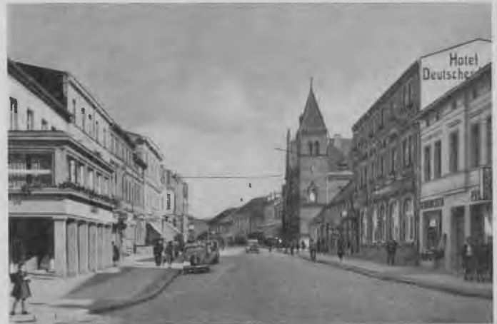
Deutsch Krone Vorn links Caffee Schmidt, rechts Hotel Deutsches Haus, das Gebäude mit Turm die Post
