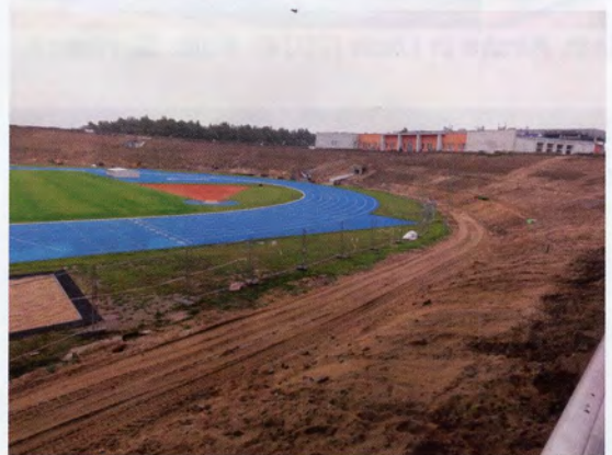
Ausbau des Stadions in Pila
