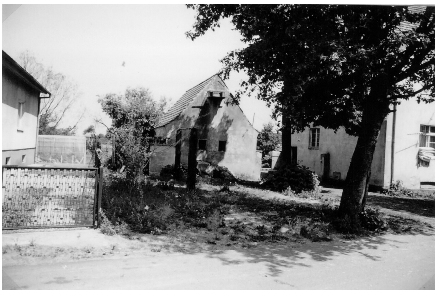
Das Stallgebäude steht noch
