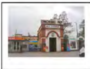
Tunneleingang zu den Bahnsteigen 2010 - der übriggebliebene Rest von der früheren Bahnhofsvorderseite
