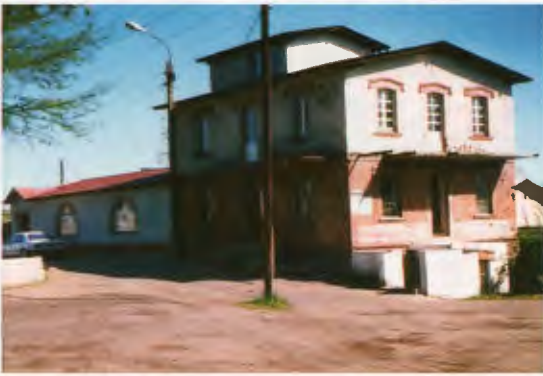
Koschützer Mühle im Umbau zum Gasthof, Juni 1994. Foto: Alfred Heymann, Essen
