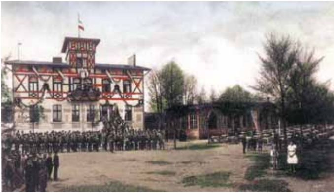
Haus der Schützengilde hinter dem Stadtspark vor 1945
