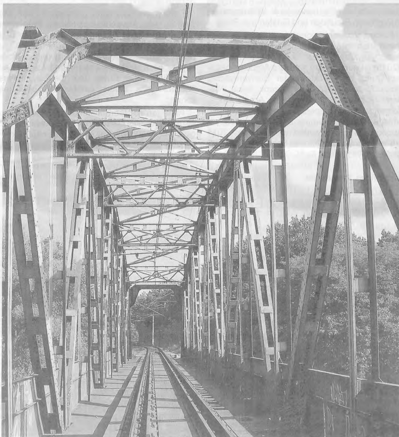
Sandseebrücke 2010 – Brücken verbinden
