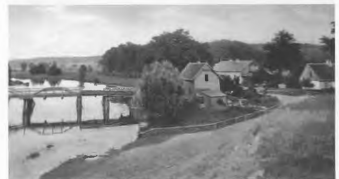
Blick auf das schöne Königsblick, noch mit der romantischen Holzbrücke und den Forsthäusern 1914
