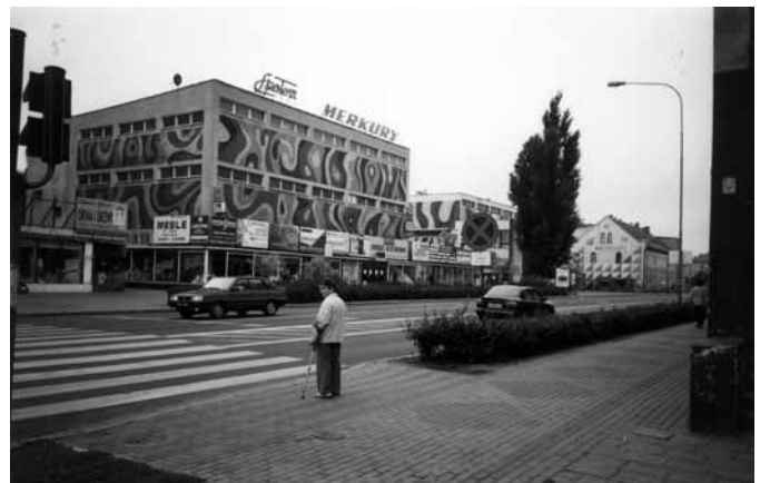
Das Eckhaus Zeughausstr. 7 wurde von den Polen nicht wieder aufgebaut. Dafür eine Ladenecke mit Reklameflächen. Aufnahme 1999, PEN.
