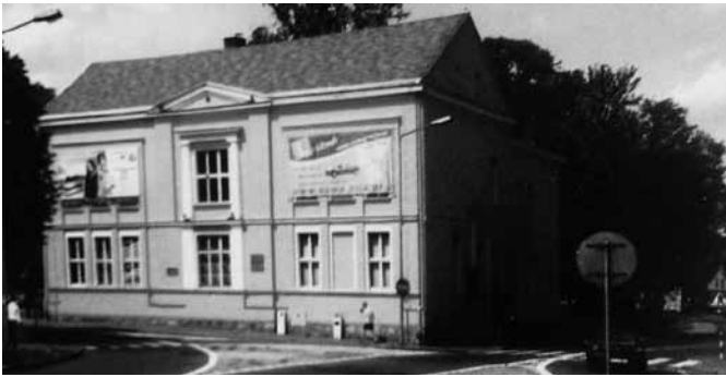
Aktuelles Foto von Gerhild Haase, Mai 2013. Das Logenhaus, Hindenburgplatz
