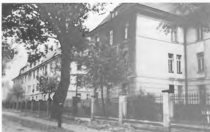
Die ehem. Kaserne der Flieger und Luftschiffer an der Gabelung Krojanker und Selgenauer Straße
