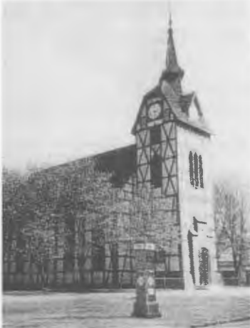
Der Fachwerkbau der ev. Kirche auf dem Marktplatz bis Februar 1945
