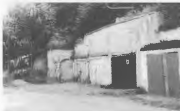
Reste des Portals zu den unterirdischen Tunneln „Geheimprojekt Detlef“. Davor sind in den späteren Jahren jämmerliche Autogaragen gebaut. Foto: Gerhild Haase, Sommer 2019
