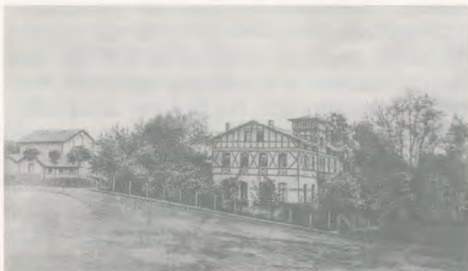
Die Südseite des Fachwerkbauwerks „Neues Schützenhaus“ Bergstr. - Im Stadtpark.
