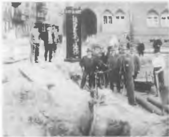
Bau der Tankstelle Albrechtstr. 109. Archiv: Erhard Rabe, Repro: Mandy Klomp
