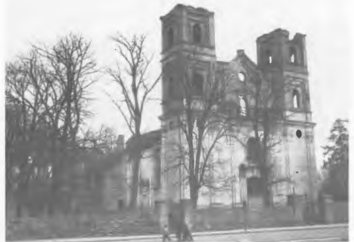
Das kath. Pfarramt, trotz gut erhaltener Bausubstanz von den Polen abgerissen! Immer wieder stellt der normal denkende Mensch die Frage: Warum? Repro: Mandy Klomp
