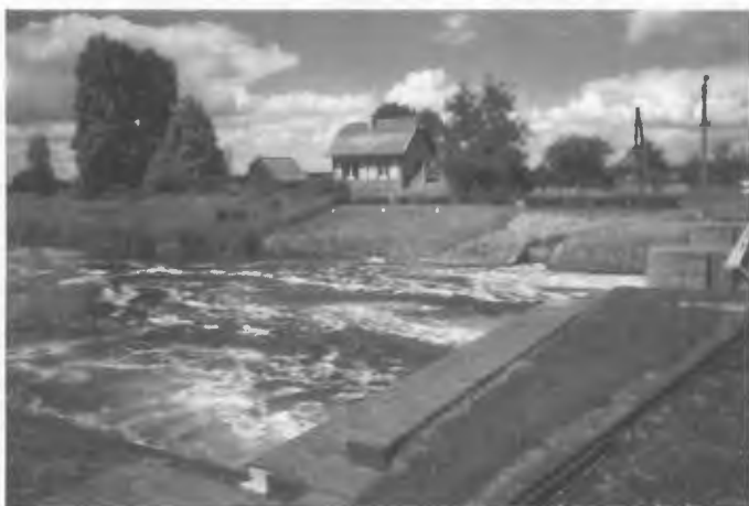
Wehrbrücke über die Netze, im Hintergrund das Haus meiner Großeltern mütterlicherseits. Mein Opa war Schleusenwärter. Der Weg führte stets über die Wehrbrücke zur Schleuse. 80 Meter lang, 12 Meter breit. Foto Dietmar Dischlatis (2014)
