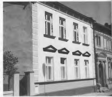
Die restaurierte Fassade des Löns-Hauses.
