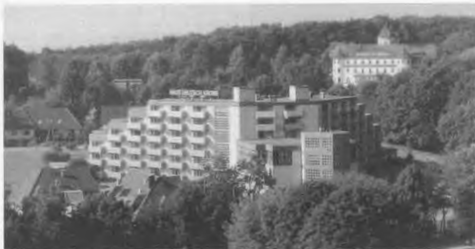
Haus Deutsch Krone in Bad Rothenfelde.
