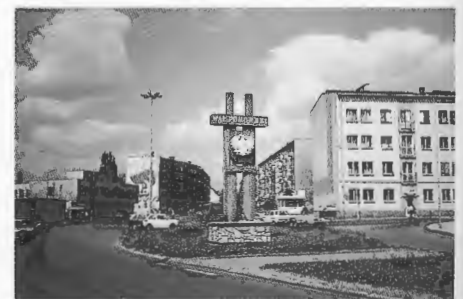
Denkmal „Pommernwall“ in Deutsch Krone, Kreuzung Schneidemühler Straße (vorn), Königsberger Straße (rechts), Schloßmühlenstraße (hinten) und Königstraße (links).
