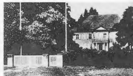
Ehemalige Oberförsterei Haugsdorf.
