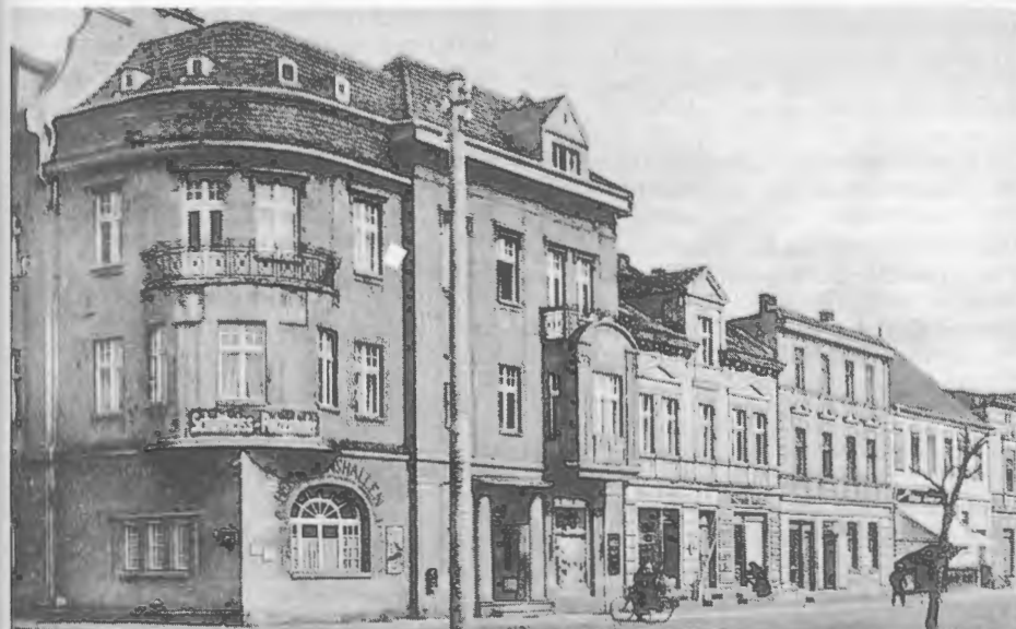
Jastrow: Die ehemaligen Hermannshallen.
