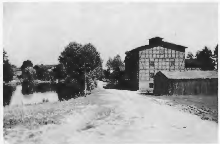
Die Mühle in Klawittersdorf vor 1945.
