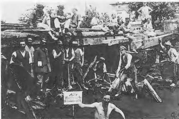
Abbruch der alten Staubrücke der Klawittersdorfer Mühle im Jahre 1927.
