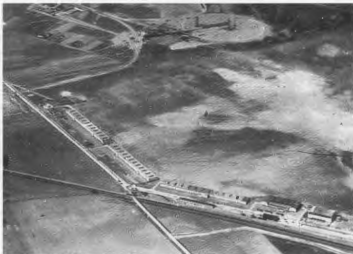
Das Fluggelände an der Selgenauer Chaussee mit der Bahnstrecke Berlin-Königsberg, an der die Fea-Werke liegen. Vor der Halle erkennt man die im Bau befindliche 232 m lange, 40 m hohe und 25 m breite Luftschiff-Drehhalle.
