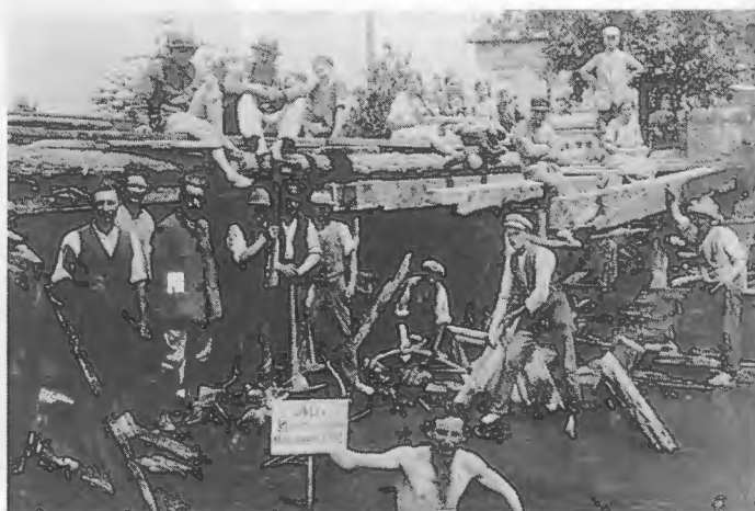
Abbruch der alten Staubrücke im Jahre 1927.
