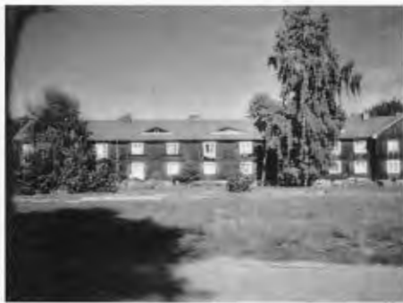
Was heute noch vom Schokoladenhaus in der Bismarckstraße steht (Aufnahme vom September 2004).
