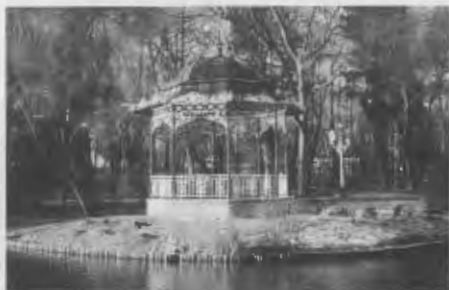
Der Pavillon im Stadtpark.
