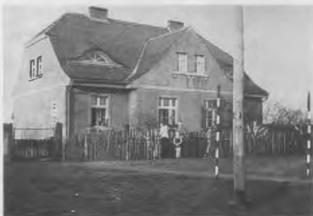
Schneidemühl, Neustettiner Strecke, Wärterhaus 5. – Aufnahme von 1936/37.
