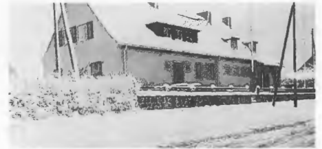
Borkendorf, neue Schule, erbaut 1935/1936.
