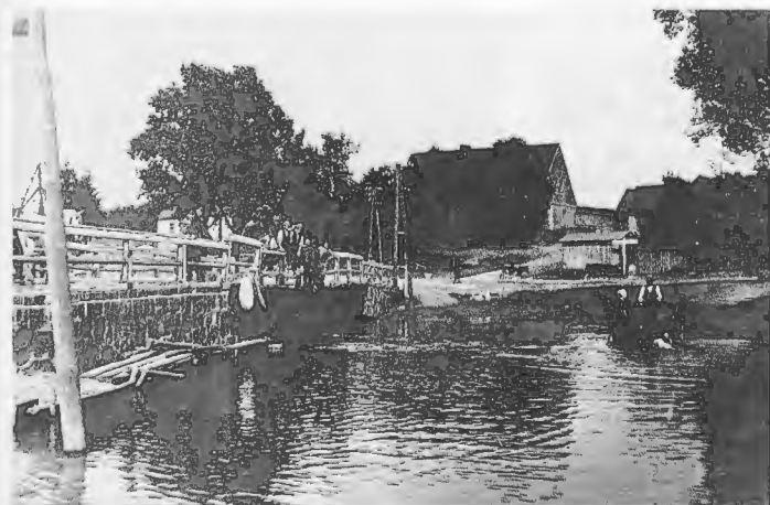
Alte Pilowbrücke und Baustelle der neuen „Weißen Brücke“ 1923. Im Hintergrund Kühe im Klawittersdorfer Weg und das Haus von Leo „Calixtus“ Pranke.
