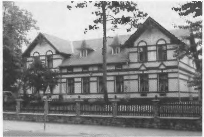
Flatower Straße 6 (heute 22); Aufnahme von 1996.
