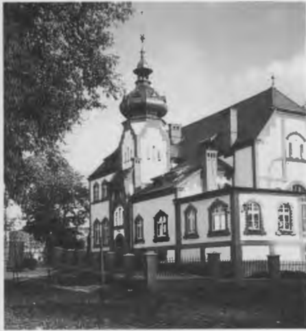
Ehemaliges Offizierskasino in Schneidemühl im Jahre 1997.
