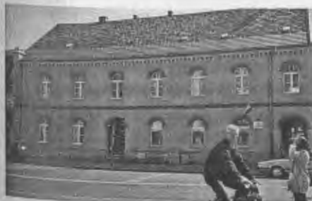
Wo steht dieses Haus in Schneidemühl/Pila? Wer erkennt es?
