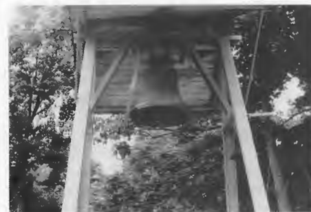
Brotzen: Der neue Glockenstuhl mit der alten Glocke.
