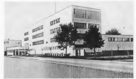
Das Schneidemühler Freiherr-vom-Stein-Gymnasium in der Handkestraße, erbaut 1931.
