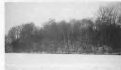
Menardsberg mit gesprengter Bunkeranlage.
