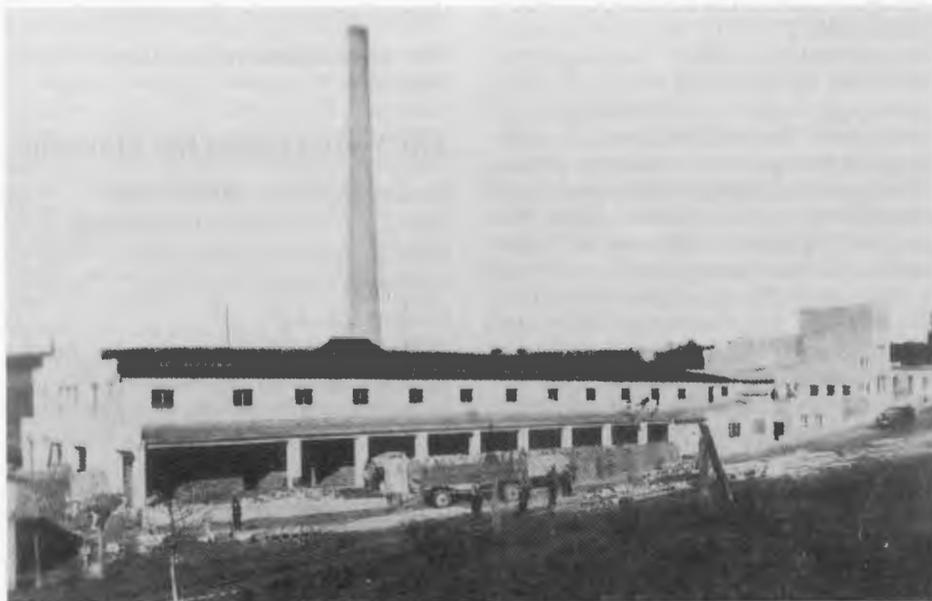
Das Kattuner Klinker- und Ziegelwerk der Stadtgemeinde Schneidemühl, das jährlich bis zu 6 000 000 Werkstücke produzierte: Hartbrandsteine, rote Vormauersteine, wasserdichte gelbe Klinker, Verblendklinker, Dachziegel sowie poröse Lang- und Querlochsteine.
