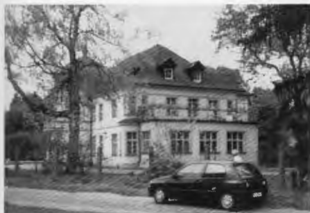
Gutshaus Wassergrund im Oktober 1998.
