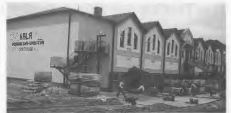
Sporthalle in Jastrow vor der Fertigstellung.
