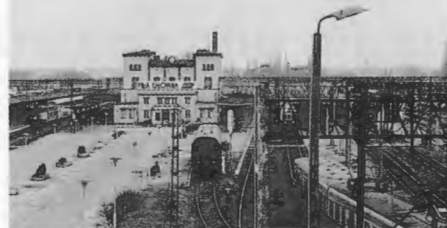
Der Bahnhof in Schneidemühl in heutiger Sicht.
