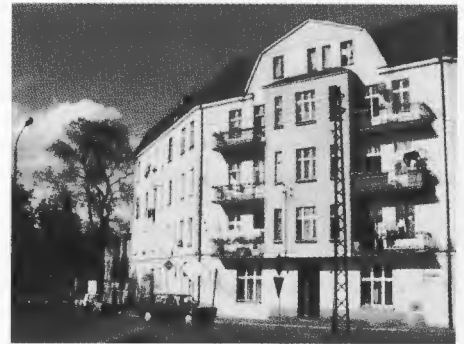
Einen neuen Anstrich bekam das Haus Nr. 56, das noch zur Albrechtstraße gehört, obwohl es schon an die Güterbahnstraße grenzt.
