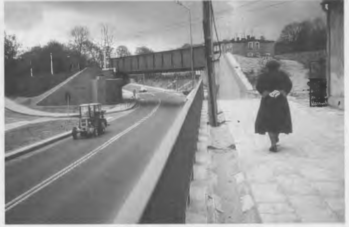
Neue Eisenbahnbrücke Bahnhofstraße/Berliner Straße.
