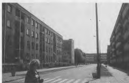
Hasselstraße von 1976, Ostseite, Blick von der Bäckerstraße in Richtung Markt, links noch alter Baumbestand.
