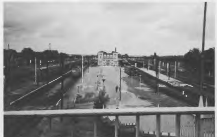
Bahnhof Schneidemühl, 1990. Von der Brücke führt eine Treppe hinunter.
