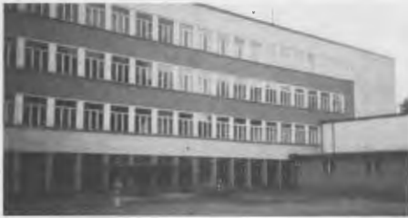
Das Gymnasium von der Hofseite mit dem Aula-Anbau.
