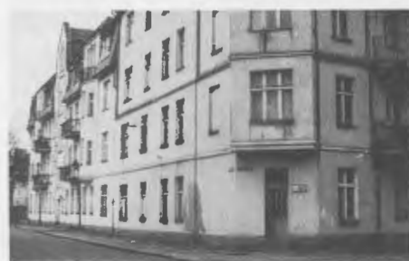
Die Wiesenstraße in Schneidemühl. — Am Anfang aufragende Häuser (heutige Ansicht).
