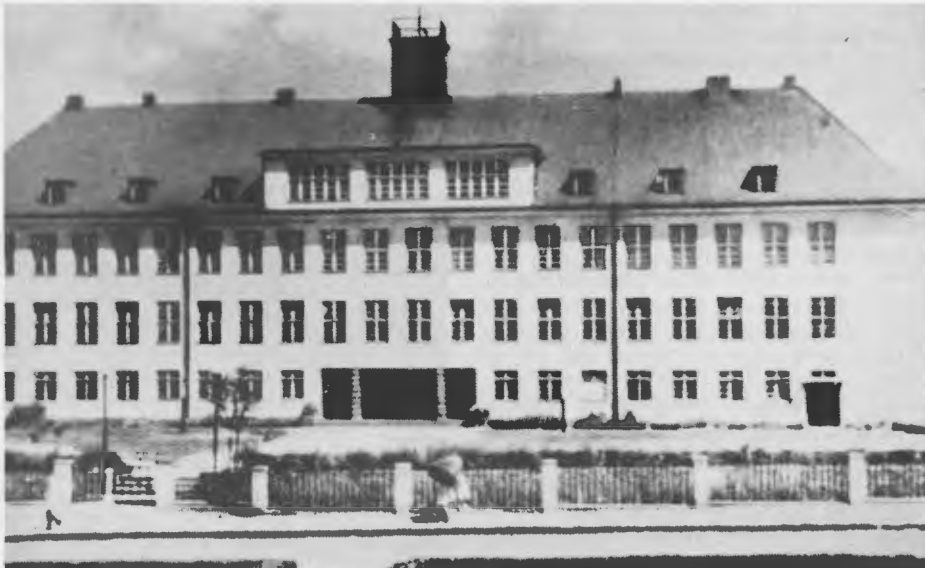
Die Neue Schule in Schloppe, erbaut 1932/33
