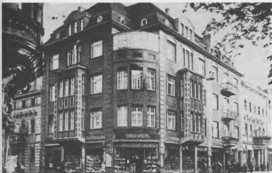
Ecke Zeughausstraße/Posener Straße. Das Eckgebäude steht auch heute noch.
