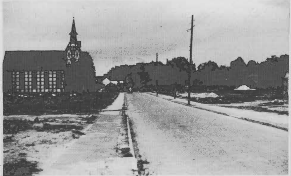
Im Hintergrund, querdurch jetzt und noch sichtbar: Amtsgericht und Amtsrichter-Wohnhaus.
