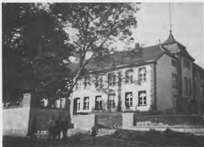
Im Jahre 1928 erfolgte ein Grundstückstausch zwischen dem Gymnasium und der Stadt. Das Gymnasium trat einen ca. 3 m breiten Geländestreifen zur Verbreiterung der Königstraße ab. Das Schulgrundstück wurde nun auch an der Königstraße durch eine massive Mauer abgeschlossen.
