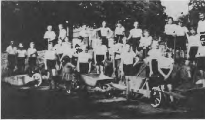
Im Jahre 1928 wurde auch der Sportplatz an der Turnhalle neu angelegt. Die Abbildung zeigt Sextaner (oder Quintaner) bei Planierungsarbeiten.
