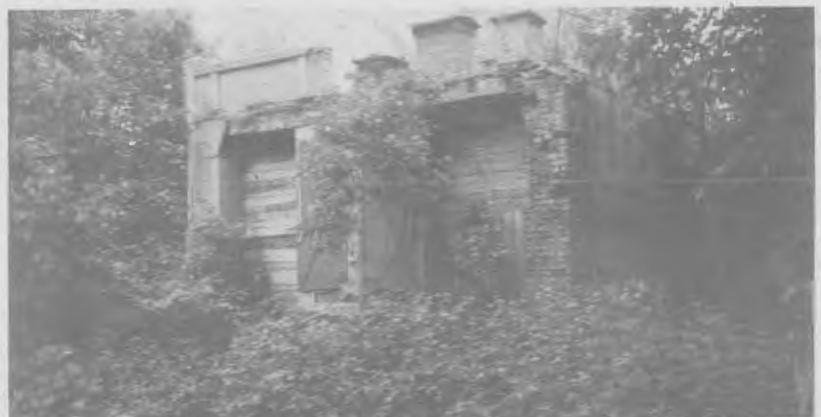
Der Rest von Schwinnings Gutshaus in Zützer.
