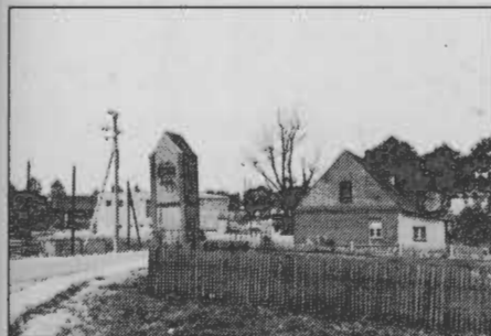
Der Neubau auf Grundstück Sonnenburg in Lebehne — Foto Klawunn.
