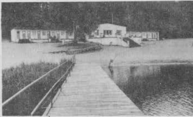
Schwimmbad Schloppe nach der Wiederherstellung
