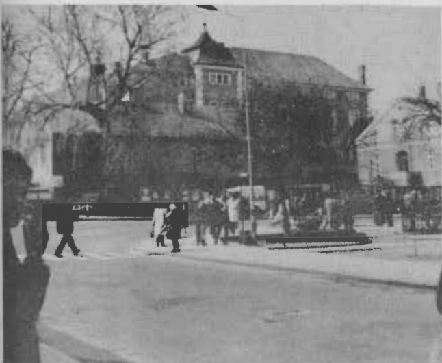
Blick Poetenstieg – Ecke Königstr. 1973 – A.Schach
