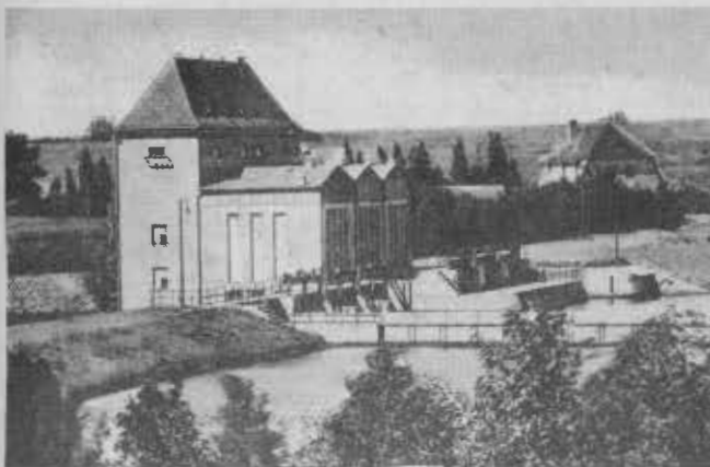
Das Stauwerk Borkendorf für die Küddow, dem rechts der Stauee vorgelagert ist.
