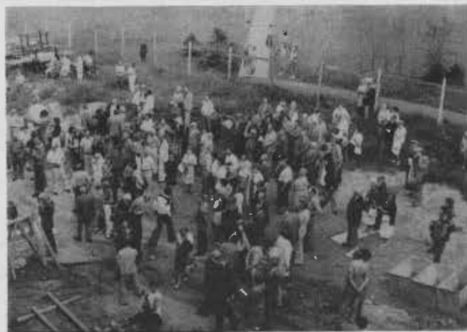
Eine Teilnehmerschar vor dem Rohbau
