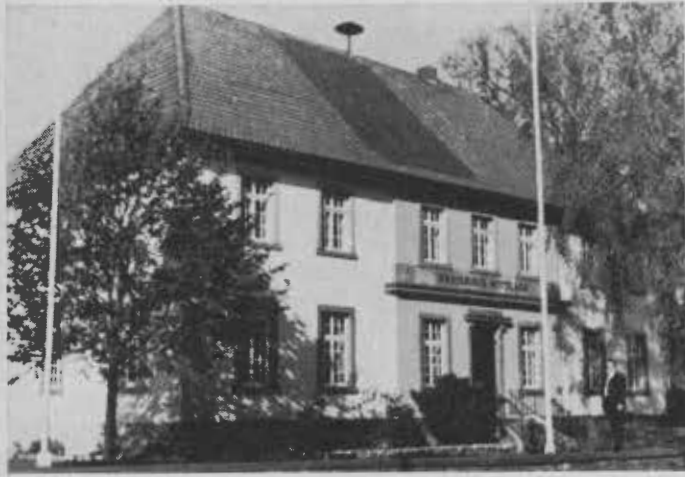
Das Kreishaus in Wittlage, das außerhalb des Burggeländes am Sitz unseres Patenkreises liegt.
