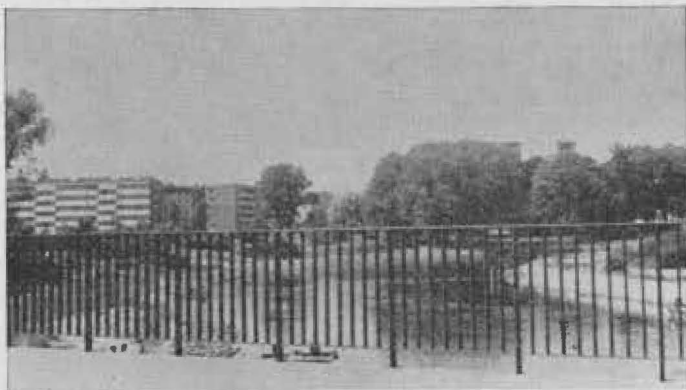
Blick von der wiederhergestellten Karl-Krause-Brücke auf Küddow-Promenade und Innenstadt.
